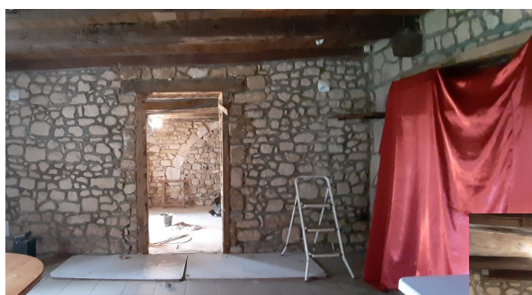
Travaux en salle annexe : Perçage du mur séparatif entre salle de réunion et nouvelle salle d'archives.
