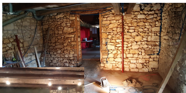
Pose d'une rampe d'accès.
